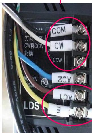
**CW/CCW, COM : points de contrôle du démarrage de la bande, raccordés avec le contact ouvert du relais DC24V.**
